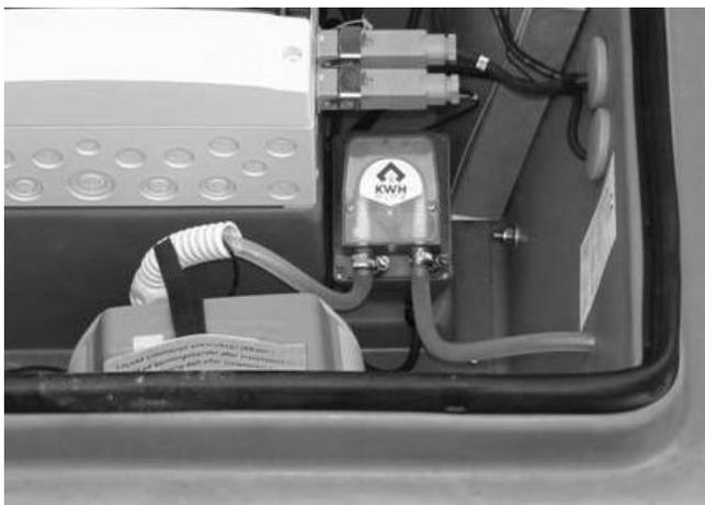
Рис 35. Насос-дозатор химического реагента
