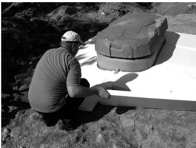
Рис. 22 Установка теплоизоляции очистного сооружения
