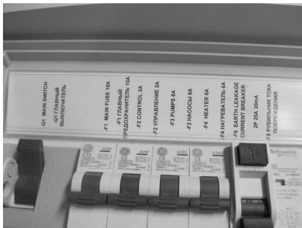
Рис 34. Панель предохранителей в блоке управления очистного сооружения
