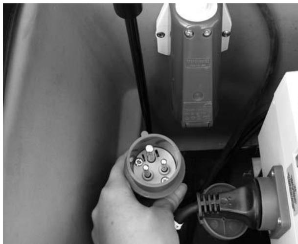
Рис. 42 Отключение основного электропитания
