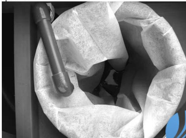
Рис 28. Мешок для накопления избыточного ила
