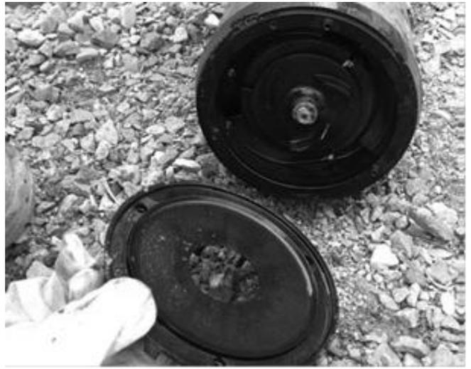
Рис 49. Чистка насосов технологического резервуара
