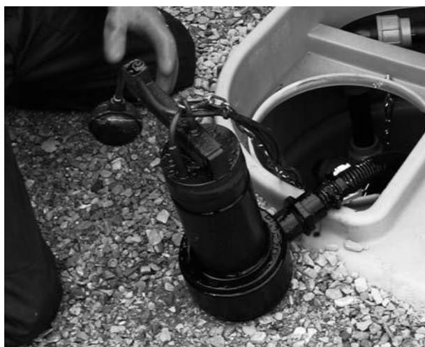
Рис. 43 Перекачивающий насос накопительного резервуара
