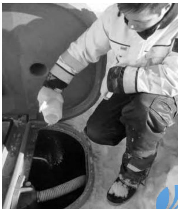
Рис. 41 Добавление извести в технологический резервуар
