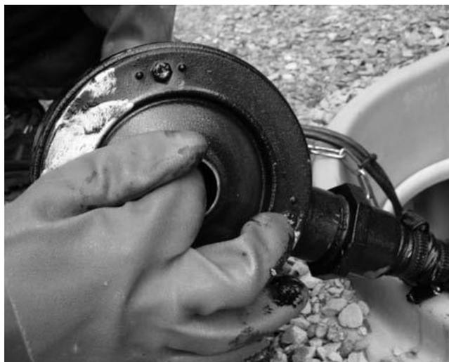
Рис 45. Очищение перекачивающего насоса
