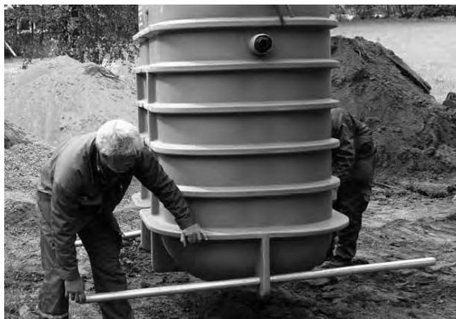
Рис 11. Установка анкерных стержней ВехоПутс 5
