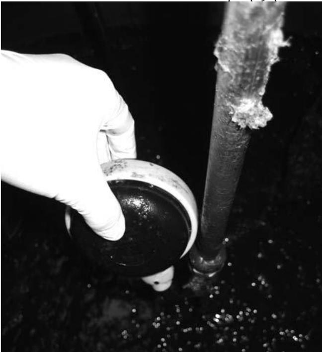
Рис 51 Очищение датчиков уровня
