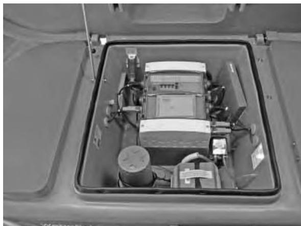
Рис 26. Машинное отделение ВехоПутс 5-10. В левом нижнем углу патрубок для добавления хим.реагента
